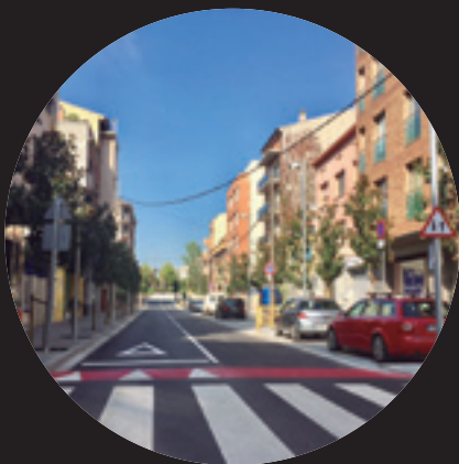
CARRETERA DE PIERA
