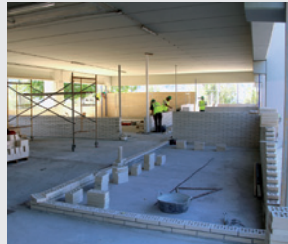
OBRES D'AMPLIACIÓ DE L'INSTITUT POMPEU FABRA. FOTO: AJM.
